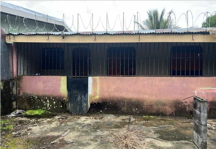
Descripción: VISTA POSTERIOR DE LA VIVIENDA
