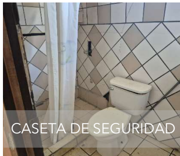
CASETA DE SEGURIDAD
