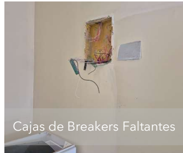
Cajas de Breakers Faltantes
