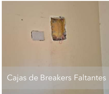
Cajas de Breakers Faltantes
