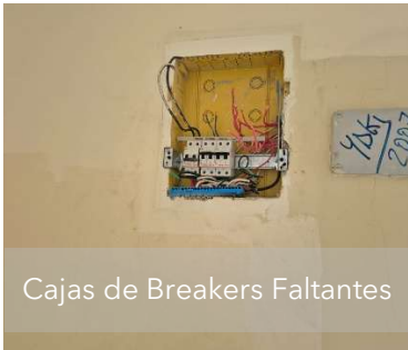
Cajas de Breakers Faltantes
