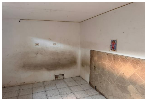
DORMITORIOS (HUMEDAD EN PAREDES Y CIELOS)
