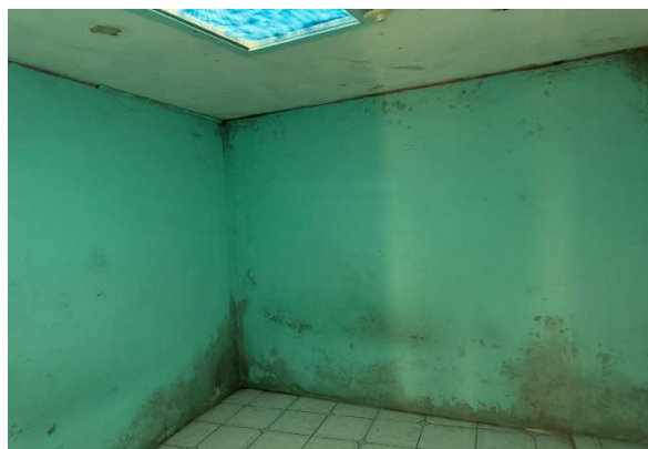
DORMITORIOS (HUMEDAD EN PAREDES Y CIELOS)
