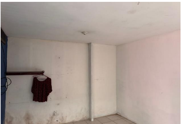
DORMITORIOS (HUMEDAD EN PAREDES)
