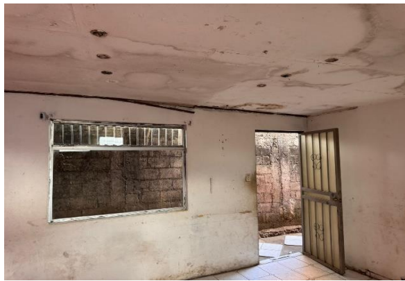
SALA COMEDOR (HUMEDAD EN PAREDES Y CIELOS)
