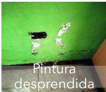
Humedad en paredes
