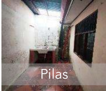
Humedad en paredes y bajantes
