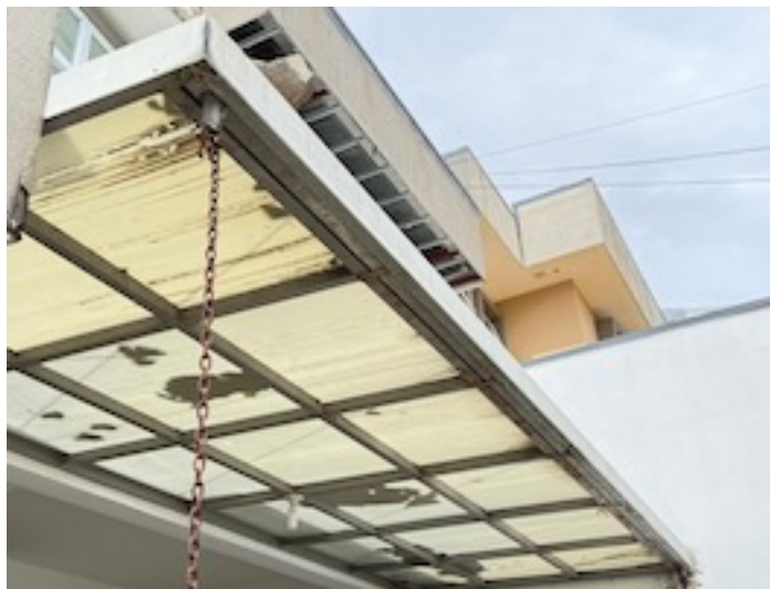
Cubierta vehiculos garaje
