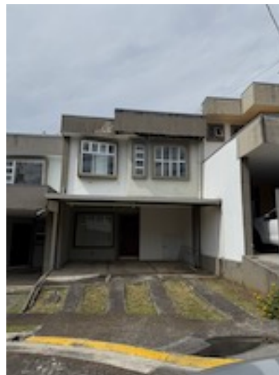
Acceso a cocheras
