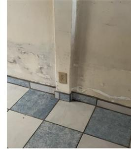
**DAÑO EN PAREDES POR EXCESO DE HUMEDAD - PRESENCIA DE HONGOS**
