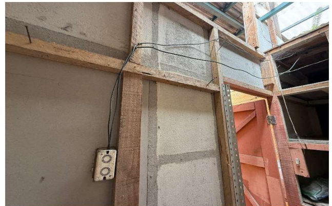
Cables expuestos en la bodega
