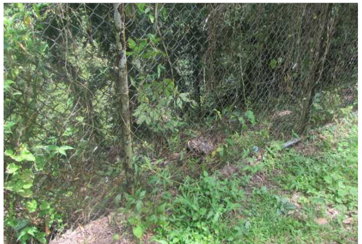
Descripción: Malla y talud
