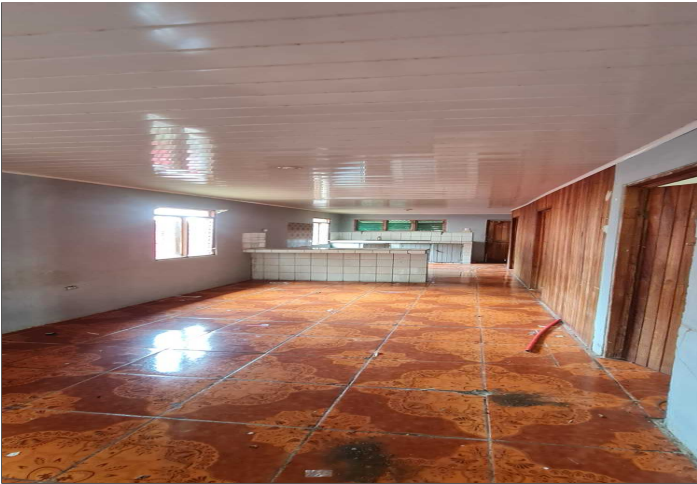
Descripción: DETALLE INTERNO
