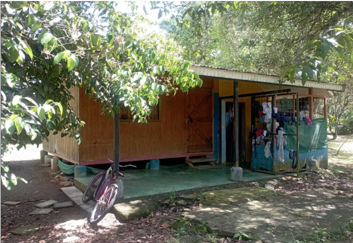
Descripción: Vista frontal de la vivienda
