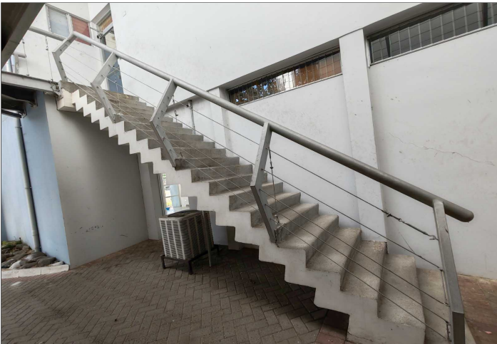
Descripción: ACCESO EXTERNO AL SEGUNDO NIVEL
