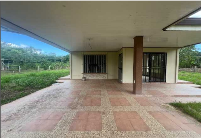
Descripción: Corredor y cochera
