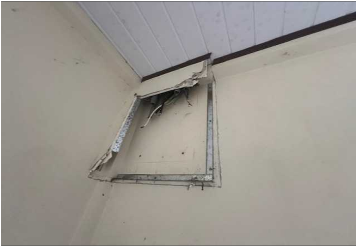
Descripción: Centro de carga removido
