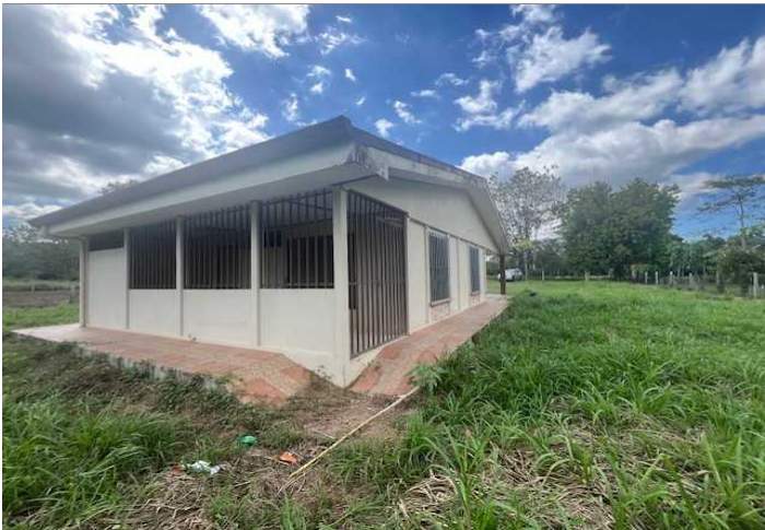
Descripción: Costado de la vivienda
