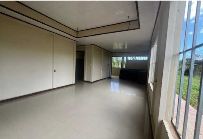
Descripción: Sala-comedor -cocina
