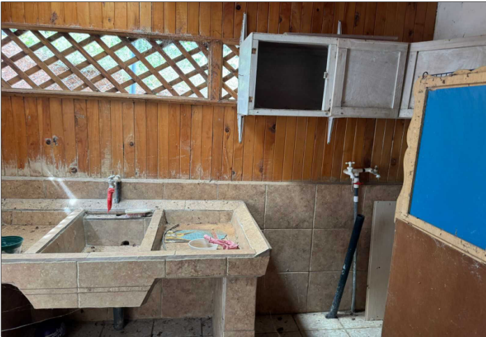
Descripción: cuarto de pilas
