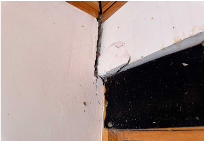
Descripción: grieta en la unión de pared de dormitorio principal
