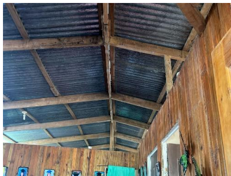
MAL ESTADO ESTRUCTURA DE TECHO
