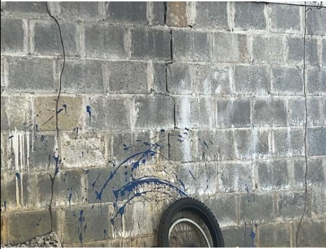
ZÓCALO DE BLOCK EXTERNO CON REVENTADURAS Y SIN REPELLO
