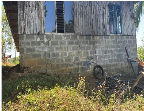
ZÓCALO DE BLOCK EXTERNO CON REVENTADURAS Y SIN REPELLO
