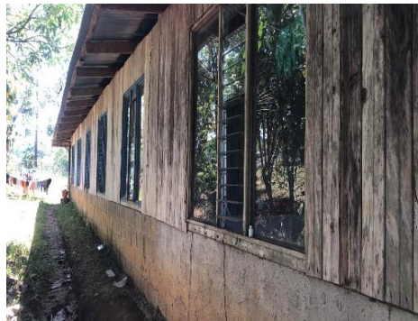
MAL ESTADO DE LAS PAREDES DE MADERA Y ESTRUCTURAS DE TECHO
