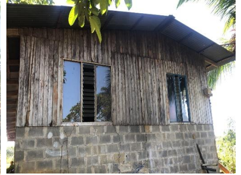
ZÓCALO DE BLOCK EXTERNO CON REVENTADURAS Y SIN REPELLO
