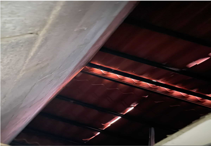
Descripción: VISTA CUBIERTA DE TECHO
