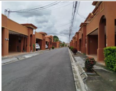
04 Entorno - Acceso Común hacia el Oeste
