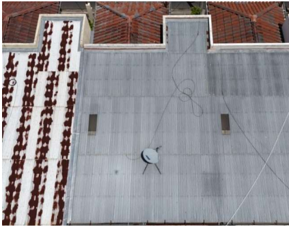
73 Estado de cubierta
