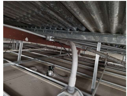
69 Instalación eléctrica, cerchas, cubierta
