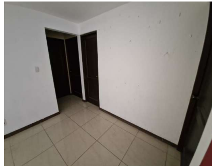
44 Vestíbulo a dormitorios
