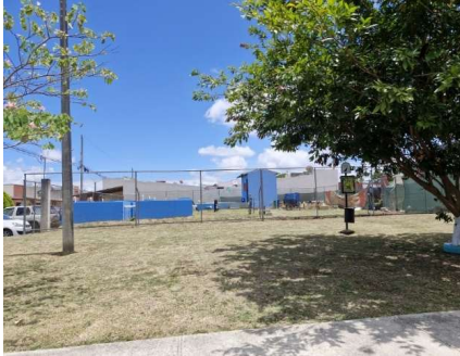
13 Planta de agua
