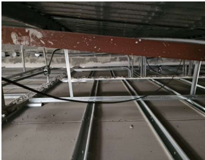
67 Instalación eléctrica, cerchas, cubierta
