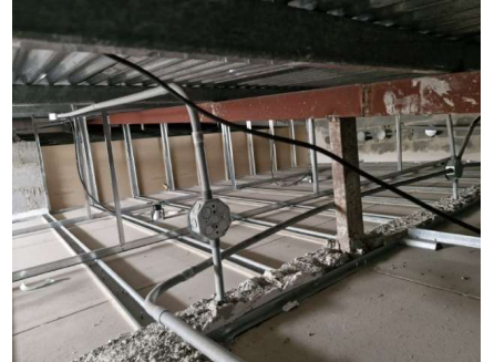
66 Instalación eléctrica, cerchas, cubierta
