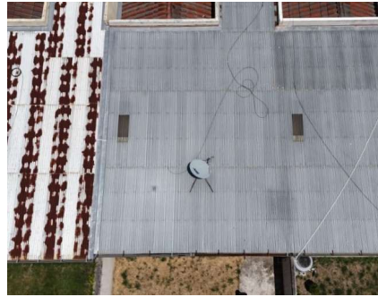
74 Estado de cubierta
