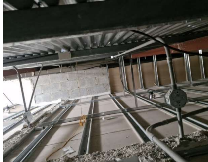
65 Instalación eléctrica, cerchas, cubierta
