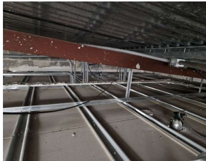
68 Instalación eléctrica, cerchas, cubierta
