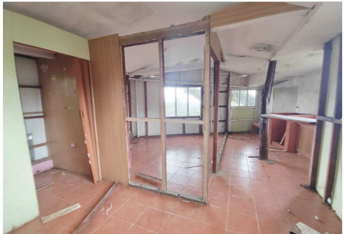
Descripción: Estructura 2 en estado de demolición
