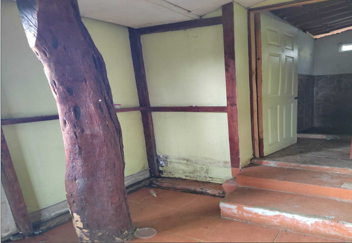
Descripción: Apart 2 para demolición
