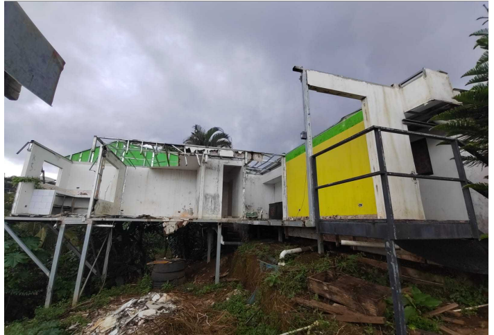
Descripción: Estructura de apartamento en estado de demolición
