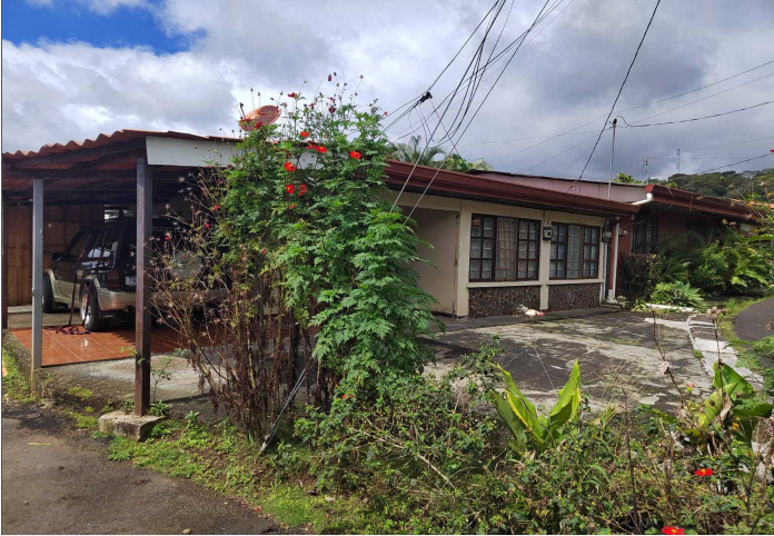
Descripción: Vista de la construcción principal
