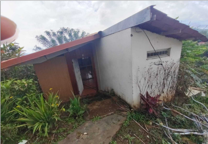
Descripción: Apartamento 2 en estado de demolición
