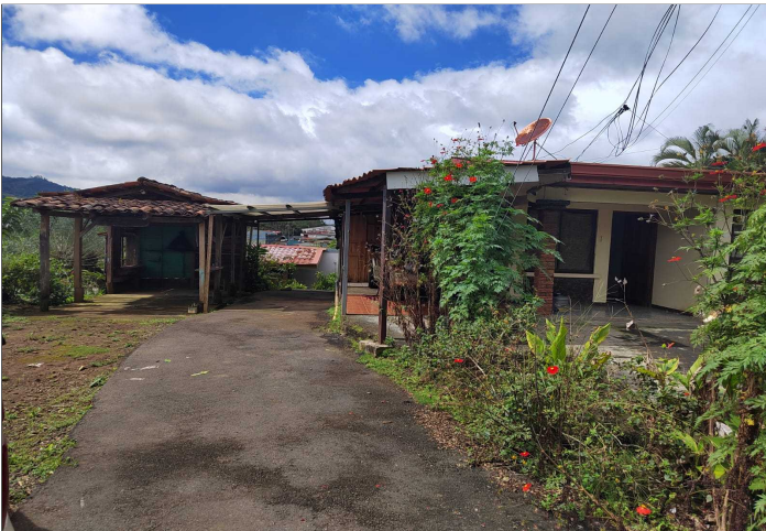
Descripción: Rancho de madera en estado de demolición
