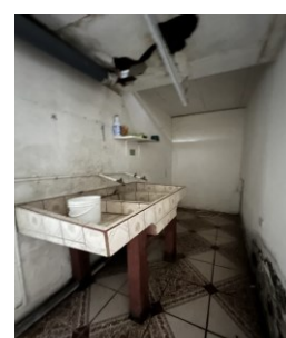
INGRESO A PILAS Y PILAS DAÑO EN PAREDES Y CIELOS
