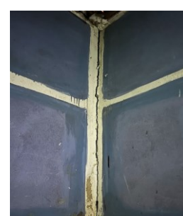
DAÑOS EN CANOAS, CIELOS Y PAREDES , GRIETAS SEPARACIÓN DE PAREDES
