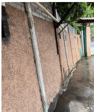
TAPIA PREFABRICADA CON DAÑO ESTRUCTURAL IMPORTANTE - OBRA A DEMOLER
