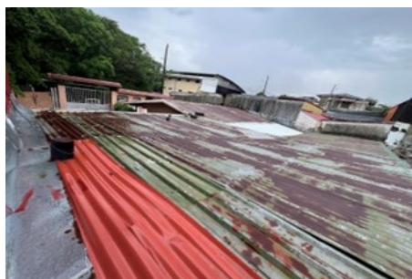
CANOAS Y CUBIERTA DE VIVIENDA 1 Y 2 EN MAL ESTADO
