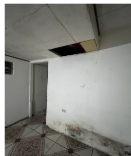
INGRESO A PILAS Y PILAS DAÑO EN PAREDES Y CIELOS
