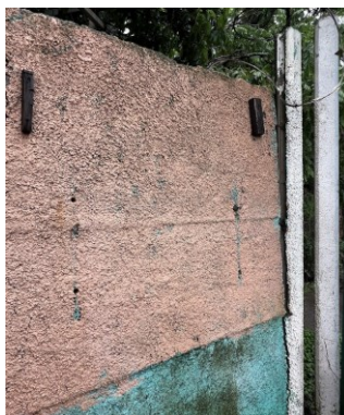
TAPIA PREFABRICADA CON DAÑO ESTRUCTURAL IMPORTANTE - OBRA A DEMOLER
