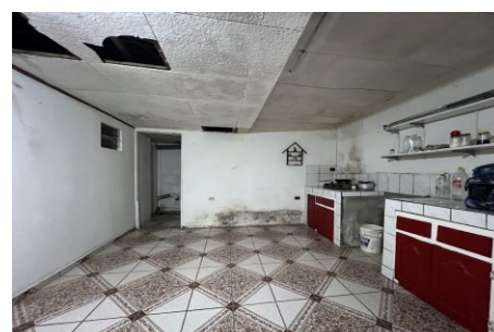
VISTAS DEL ÁREA DE LA COCINA Y PUERTA A PILAS DAÑOS EN CIELO Y PAREDES - CANOA INTERNA
