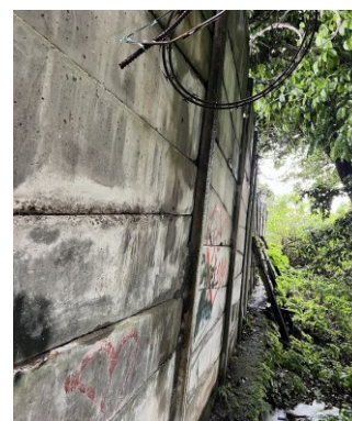
TAPIA PREFABRICADA CON DAÑO ESTRUCTURAL IMPORTANTE - OBRA A DEMOLER
