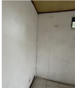
GRIETAS EN PAREDES Y PISO
