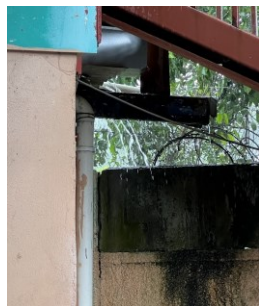
CANOAS Y CUBIERTA DE VIVIENDA 1 Y 2 EN MAL ESTADO
