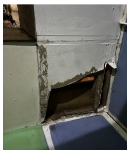
DAÑOS EN CANOAS, CIELOS Y PAREDES , GRIETAS SEPARACIÓN DE PAREDES
