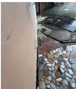
GRIETAS EN PAREDES Y PISO
