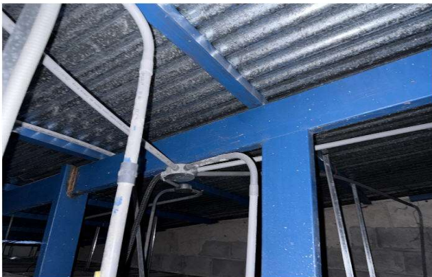
Parte de la estructura de techo
