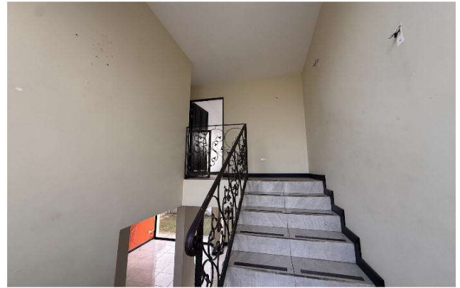
Escaleras al segundo nivel
