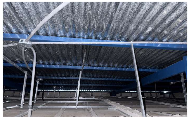
Parte de la estructura de techo
