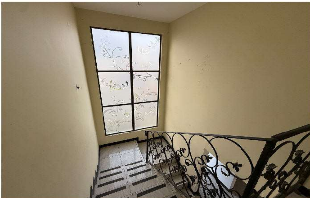
Vista de escaleras
