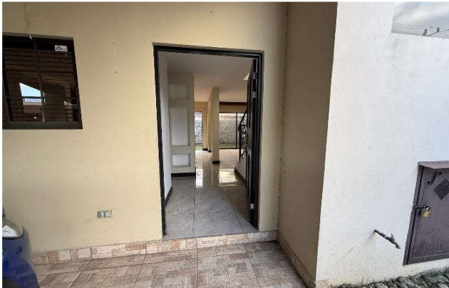
Puerta de entrada a la vivienda
