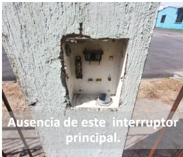
Vista de base de medidor eléctrico.
