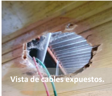
Vista de cables expuestos.
