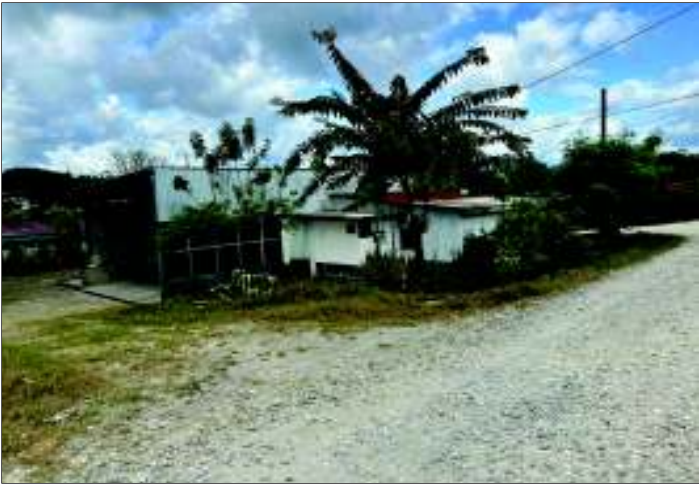
Descripción: Vista de la construcción desde vertice 4 al 1
