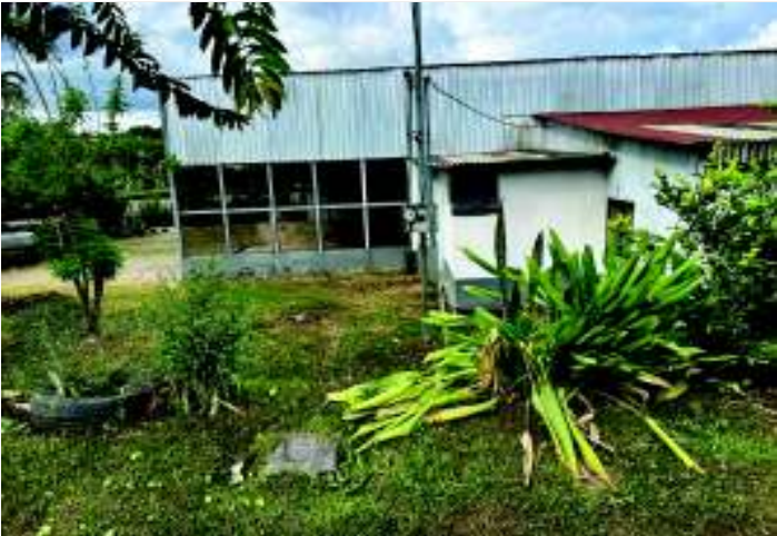
Descripción: Agua y electricidad instaladas
