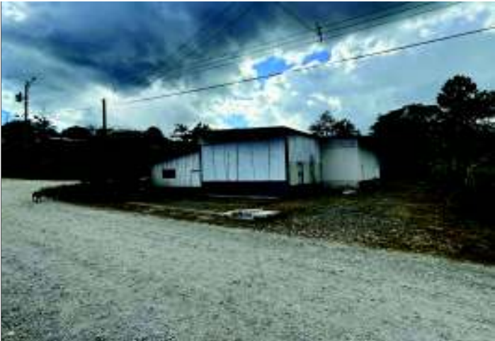
Descripción: Lindero Este, frente calle publica, fachada principal construccion
