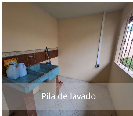
Utilización de canaleta PVC, en circuito expuesto
