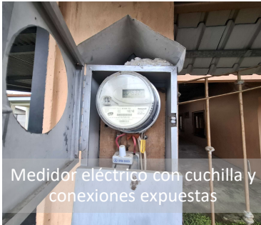
Medidor eléctrico con cuchilla y conexiones expuestas
