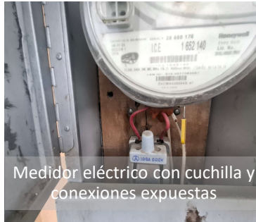
Medidor eléctrico con cuchilla y conexiones expuestas
