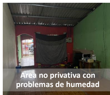
Parcial interna del techo
