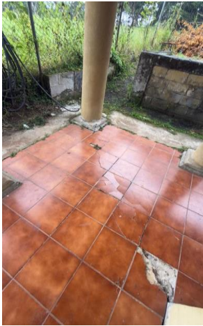
Vistas deterioro físico del corredor, agrietamientos de piso y acera perimetral . Desprendimiento entre piso corredor y acera
