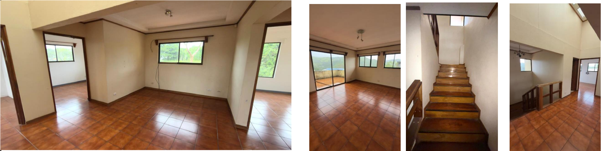
Vistas área comedor, nótese piso interno y paredes en buen estado
