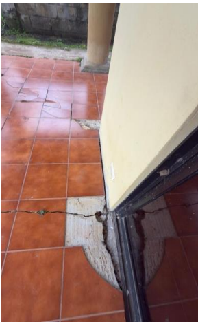
Vistas deterioro físico del corredor, agrietamientos de piso y acera perimetral . Desprendimiento entre piso corredor y acera
