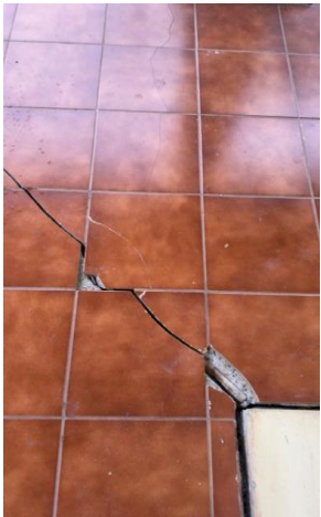
Vistas deterioro físico del corredor, agrietamientos de piso y acera perimetral . Desprendimiento entre piso corredor y acera
