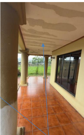
Vista deterioro cielos por humedad
