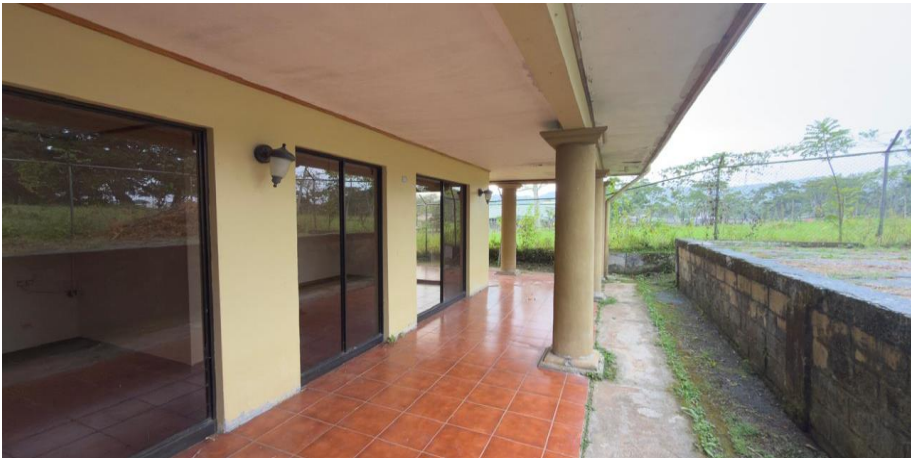
Vista externa corredor perimetral posterior
