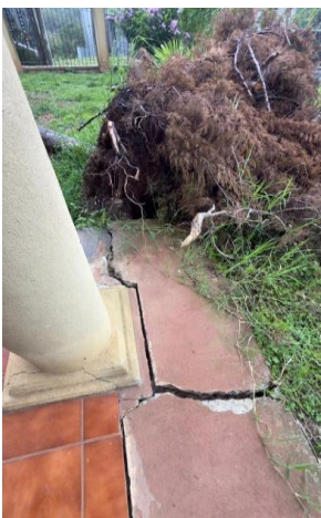
Vistas deterioro físico del corredor, agrietamientos de piso y acera perimetral . Desprendimiento entre piso corredor y acera
