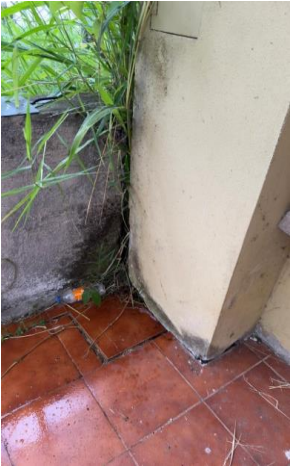
Vistas deterioro físico del corredor, agrietamientos de piso y acera perimetral . Desprendimiento entre piso corredor y acera
