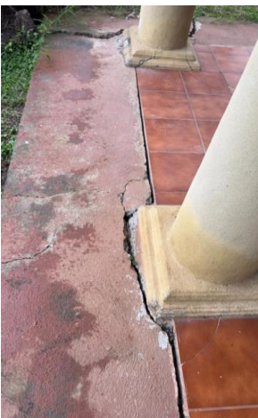
Vistas deterioro físico del corredor, agrietamientos de piso y acera perimetral . Desprendimiento entre piso corredor y acera
