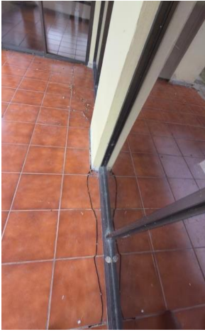
Vistas deterioro físico del corredor, agrietamientos de piso y acera perimetral . Desprendimiento entre piso corredor y acera
