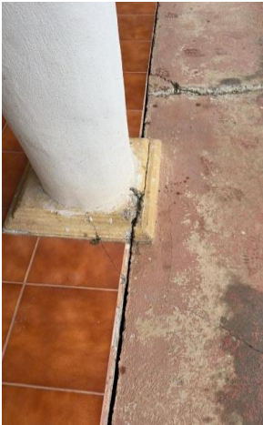
Vistas deterioro físico del corredor, agrietamientos de piso y acera perimetral . Desprendimiento entre piso corredor y acera
