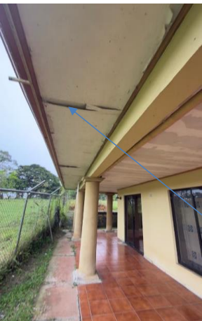
Vista deterioro cielos por humedad
