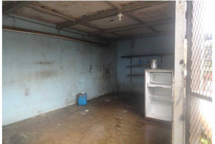
Descripción: Se observa la estructura del entepiso y la instalación eléctrica, problemas por la humedad.
