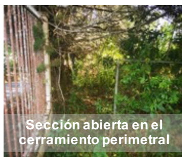
Área abierta contiguo al muro frontal para entrada al inmueble
