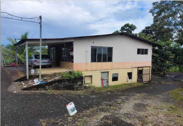
Descripción: Vista de vivienda dos planta de concreto en el frente
