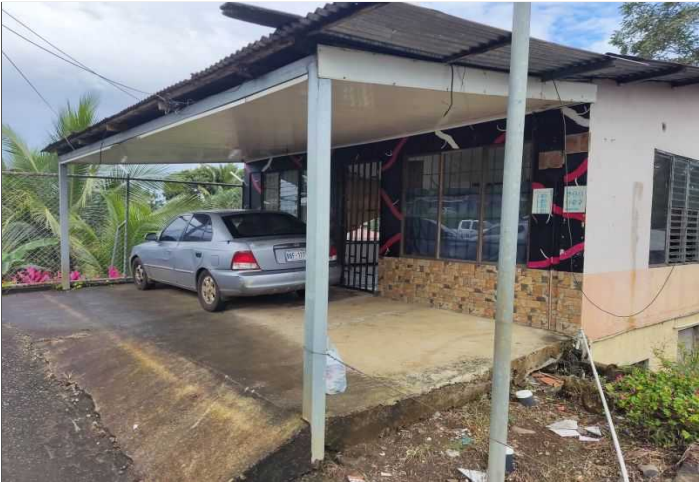
Descripción: Vista de corredor en el frente y entrada principal
