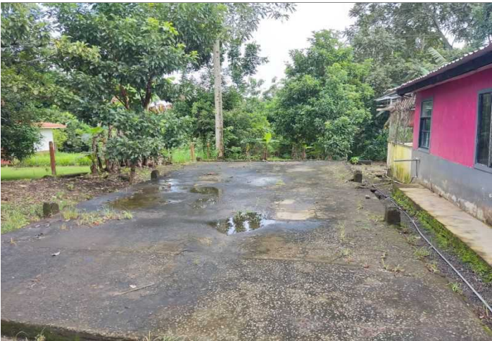
Descripción: Vista de planché de concreto, antes con un galerón que fue desmantelado
