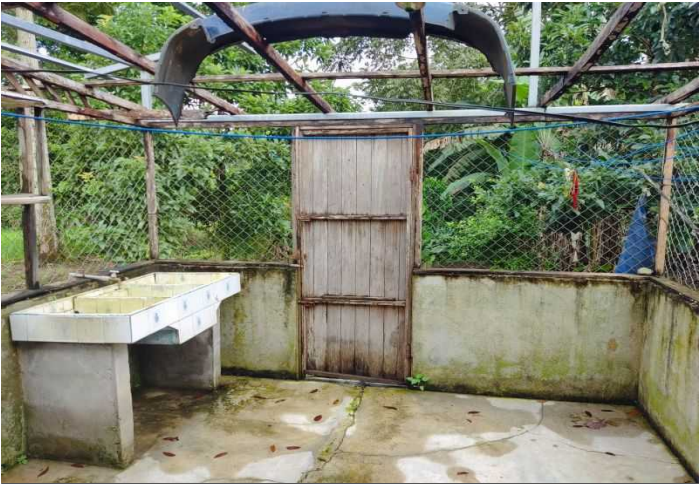
Descripción: Vista interior de cuarto de pilas desmantelado
