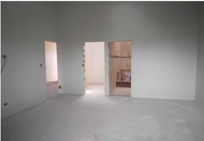
Descripción: Dormitorio principal / Remoción de puertas internas
