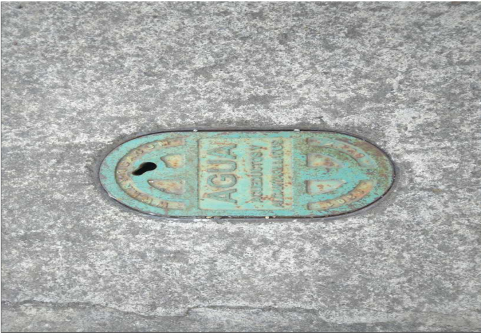
Descripción: Medidor de Agua
