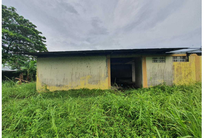
Descripción: CONSTRUCCIÓN ABANDONADA
