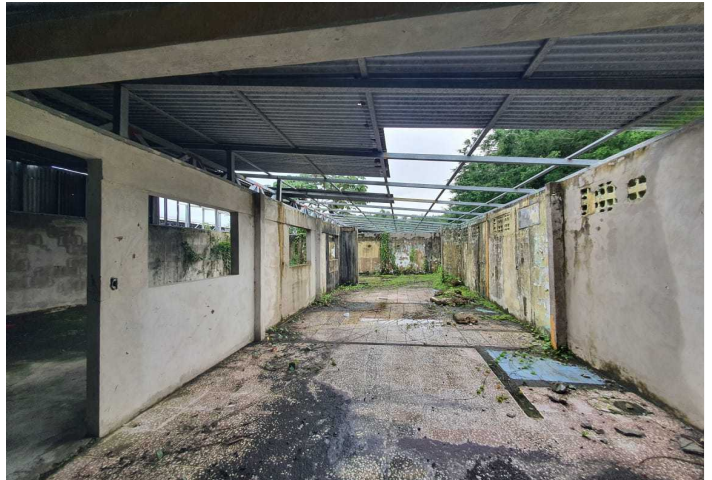
Descripción: CONSTRUCCIÓN ABANDONADA
