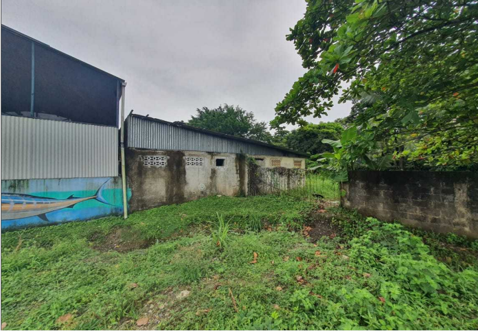
Descripción: INTERIOR DEL TERRENO
