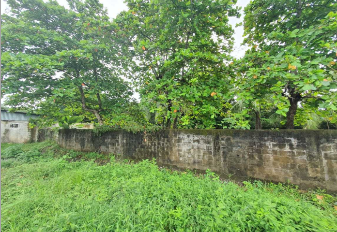
Descripción: INTERIOR DEL TERRENO
