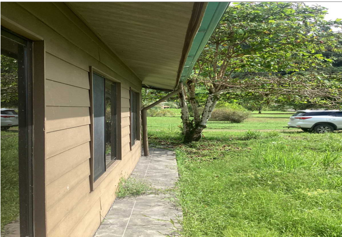
Descripción: FACHADA LATERAL DERECHA
