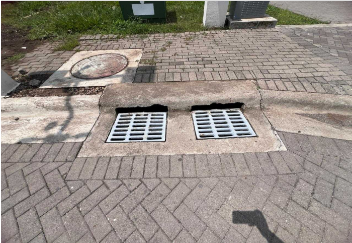
Descripción: Alcantarillado Pluvial
