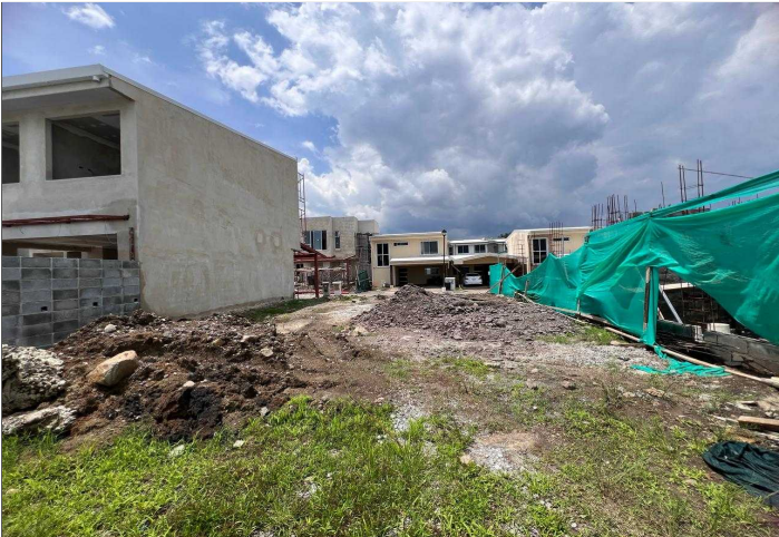
Descripción: Vista Interna de Finca Filial N° 7 - Bloque R - Tomada de Oeste a Este
