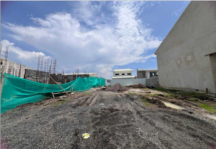
Descripción: Vista Interna de Finca Filial N° 7 - Bloque R - Tomada de Este a Oeste
