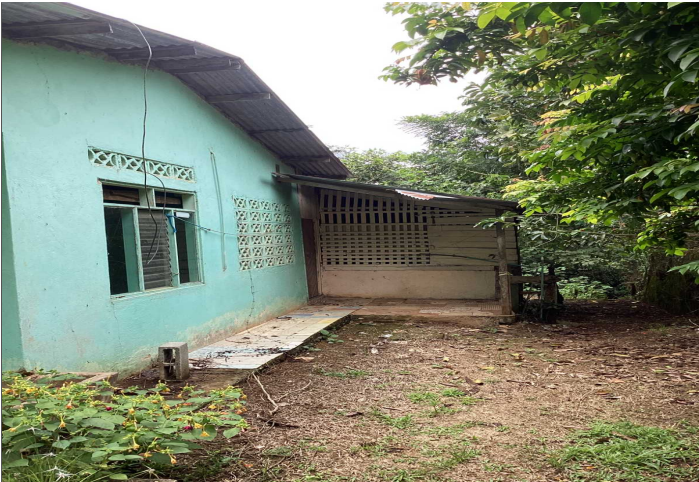
Descripción: FACHADA LATERAL DERECHA
