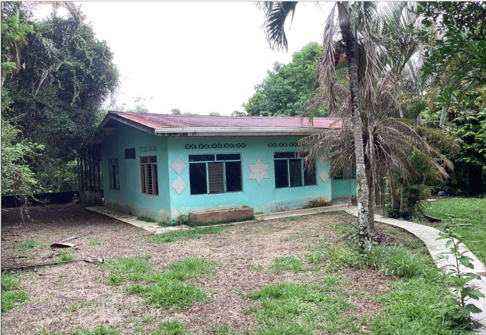
Descripción: FACHADA PRINCIPAL
