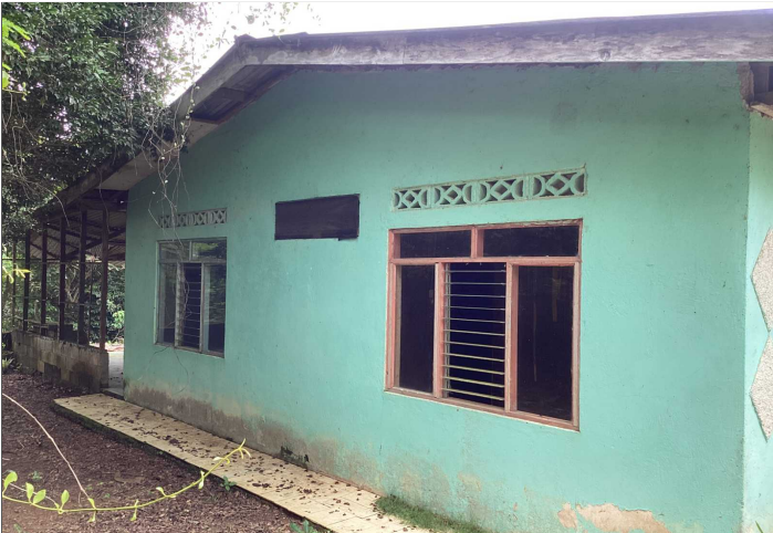
Descripción: FACHADA LATERAL IZQUIERDA
