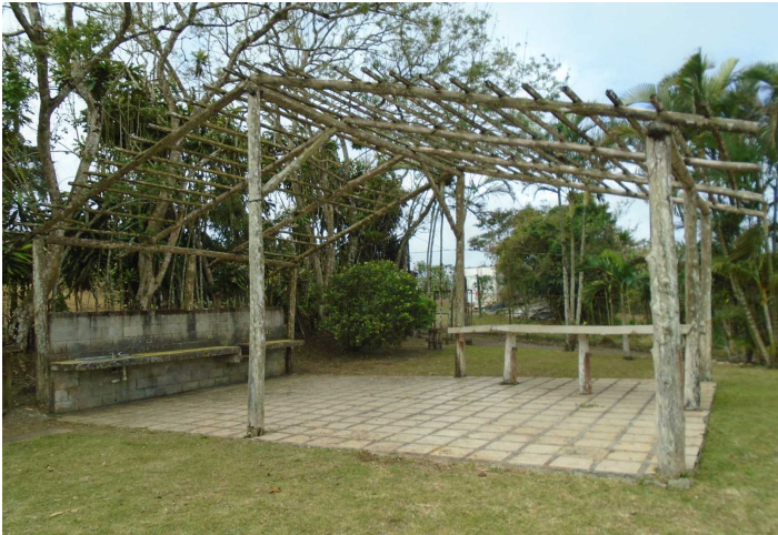
Descripción: Rancho (Área de concreto)
