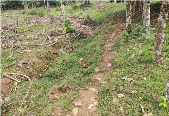
Descripción: Detalle de canal de salida de aguas pluviales por el lindero Oeste
