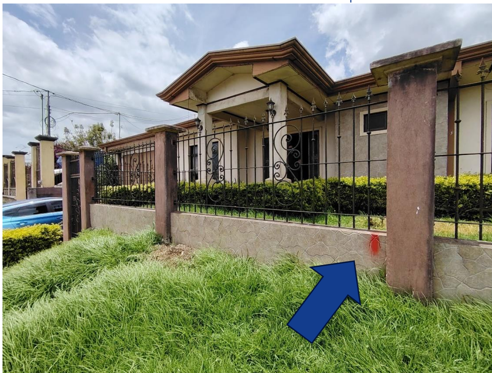
Imagen 2. Fotografía donde se muestra la marca del vértice 3 del plano catastrado, de la marca para la izquierda le pertenece al Banco Nacional
