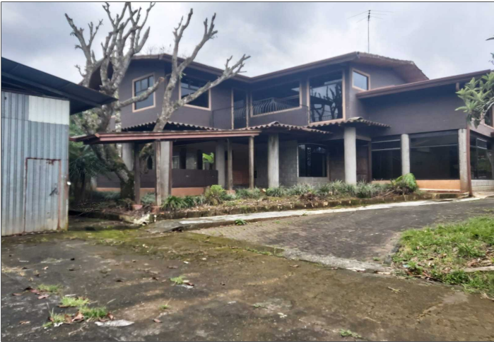
Descripción: Vista de la casa
