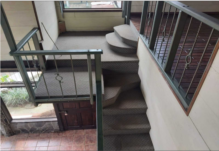
Descripción: Gradas y vacío 2 planta
