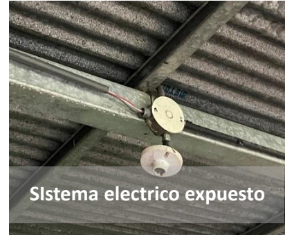
Sistema electrico expuesto
