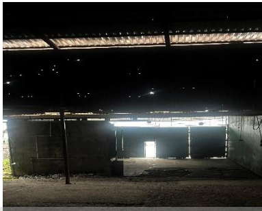
Vista interna de construcción
