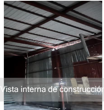
Vissta interna de construcción
