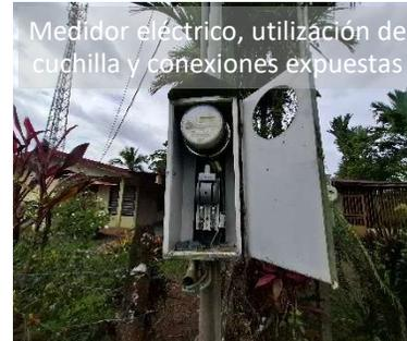
Medidor eléctrico, utilización de cuchilla y conexiones expuestas
