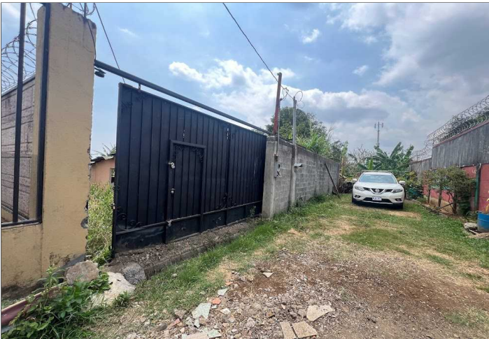
Descripción: FRENTE PRINCIPAL DE LA PROPIEDAD - PORTÓN EN PERFILES HN Y TAPIA EN MAMPOS
