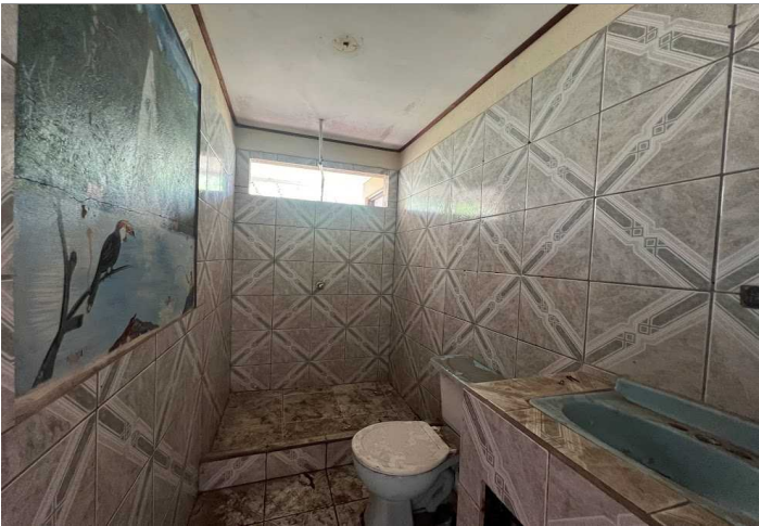
Descripción: SERVICIO SANITARIO
