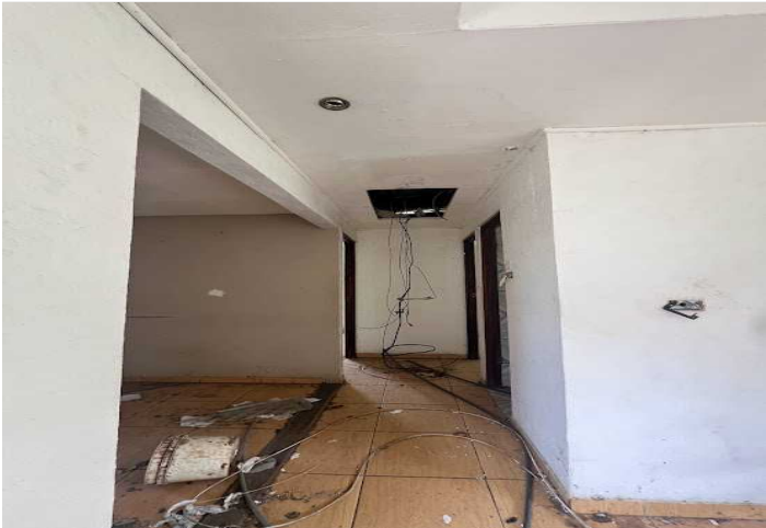
Descripción: PASILLO A DORMITORIOS
