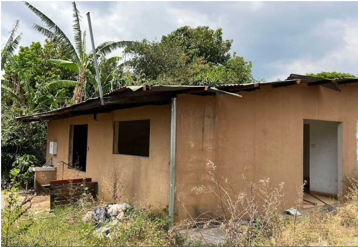
Descripción: ESTRUCTURA DE TECHOS Y CUBIERTA EN ESTADO DE DEMOLICIÓN
