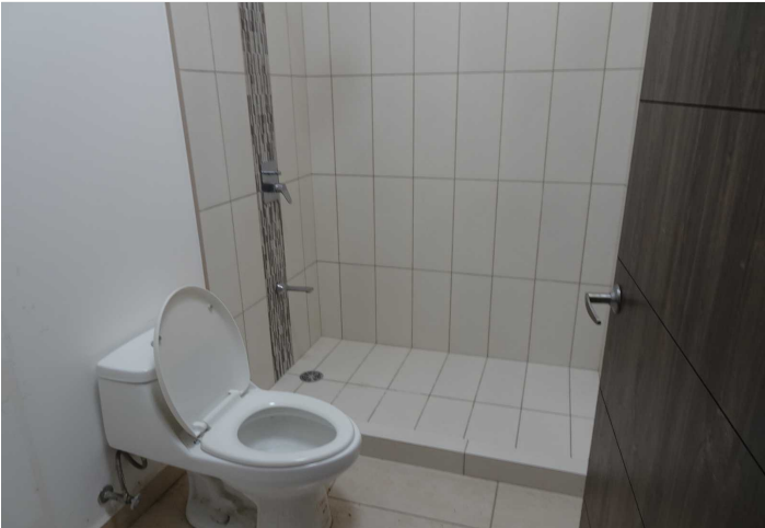
Descripción: DETALLE DE BAÑOS
