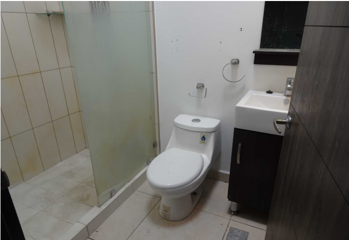
Descripción: DETALLE DE BAÑOS
