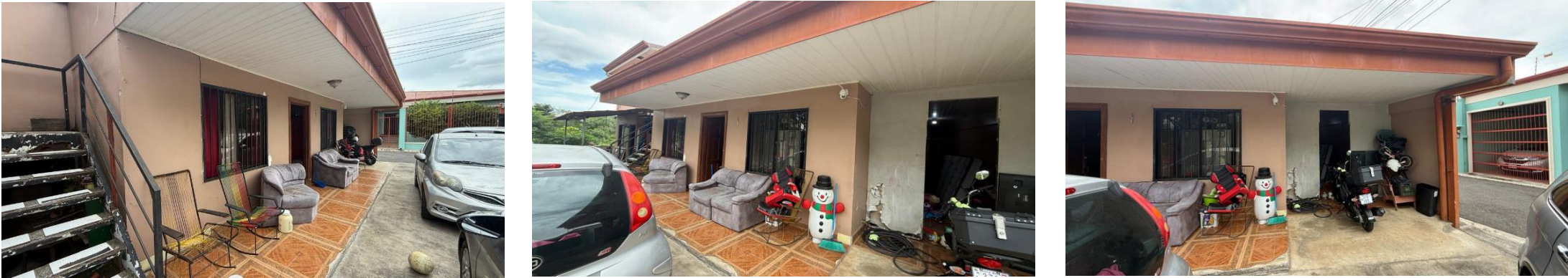
Vista externade casa y corredor
