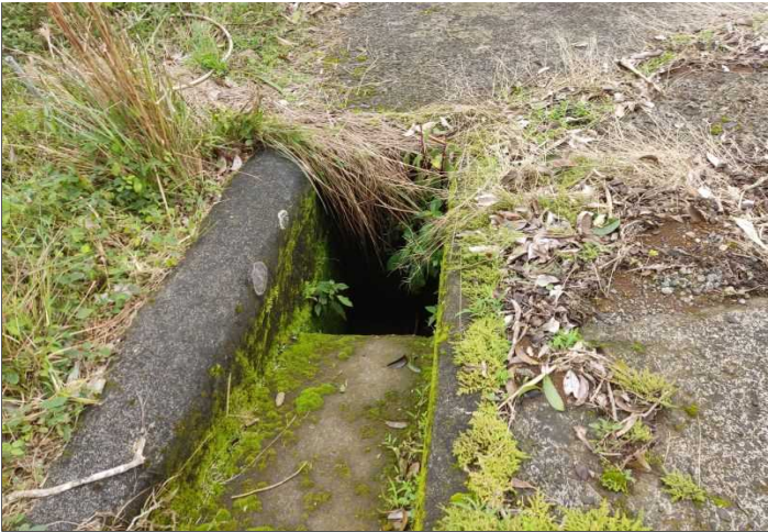
Descripción: Detalle de caño para captación y salida de aguas pluviales
