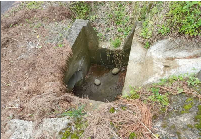
Descripción: Caja de aguas pluviales y alcantarillado en la calle pública
