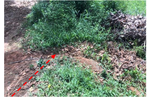
INGRESO DE AGUAS PLUVIALES DE LA CALLE AL PREDIO, POR FALTA DE CAÑO NATURAL
