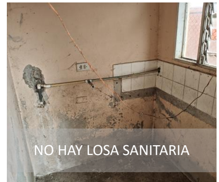
HUMEDAD EN LA PAREDES
