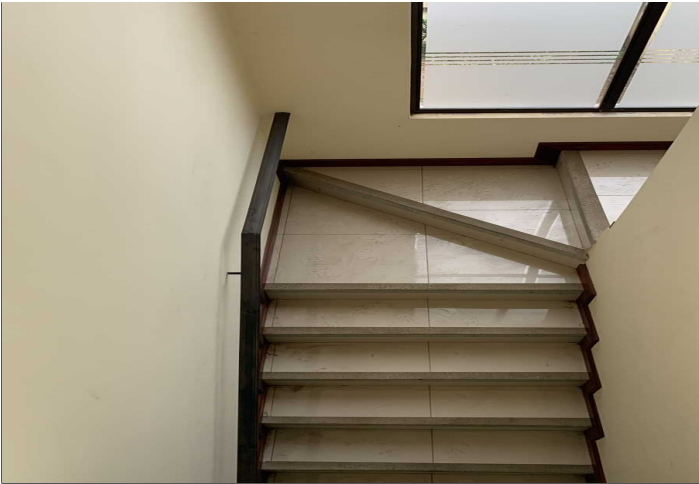
Descripción: Núcleo escaleras
