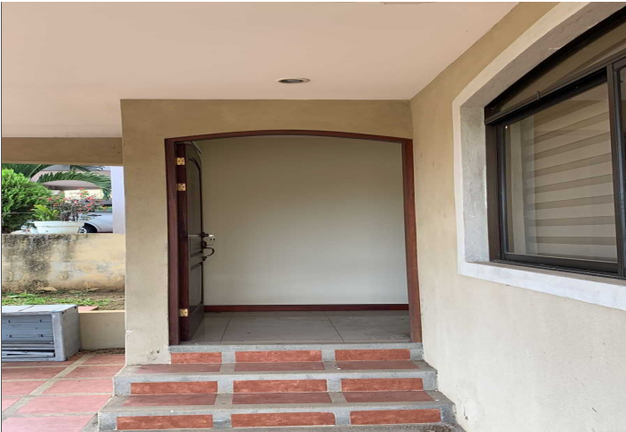
Descripción: Vista ingreso puerta principal
