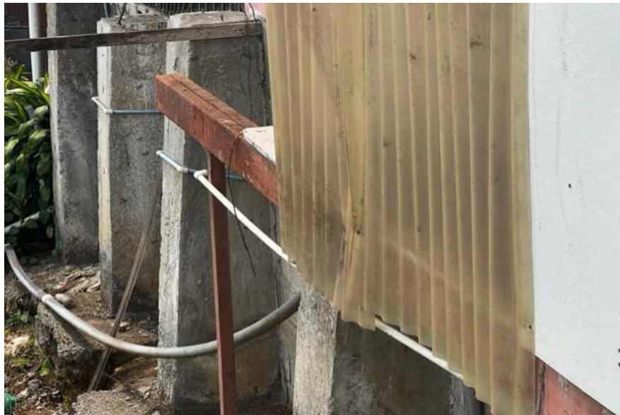
TIPO DE CIMENTACION OBSERVADO EN LA CASA
