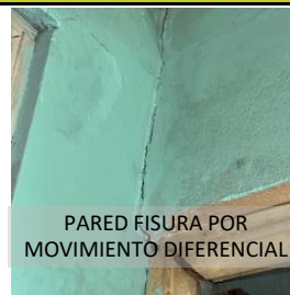
FISURA EN PARED Y BUQUE DE VENTANA
