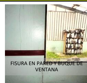
PARED FISURA POR MOVIMIENTO DIFERENCIAL
