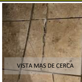
PARED FISURA POR MOVIMIENTO DIFERENCIAL
