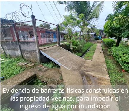
Evidencia de barreras físicas construidas en las propiedad vecinas, para impedir el ingreso de agua por inundación
