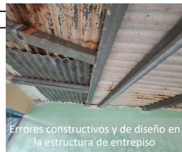
Errores constructivos y de diseño en la estructura de entpiso
