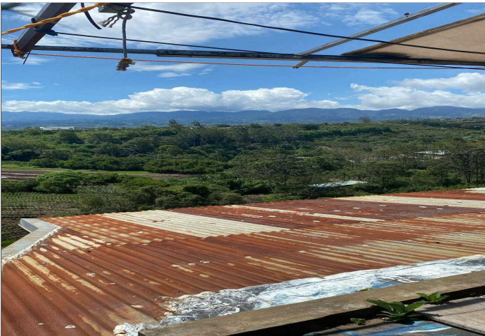
Descripción: Detalle cubierta de techo
