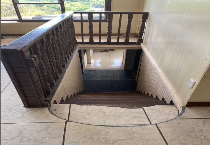
Descripción: Ducto escaleras
